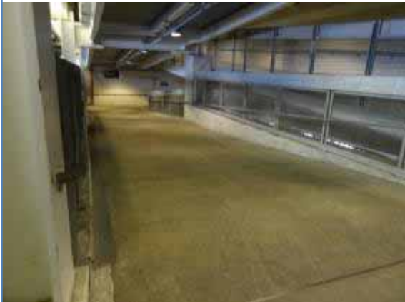
スロープ (ヤンキースタジアム)
